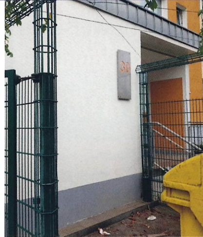
vor Fassadenreinigung und danach
