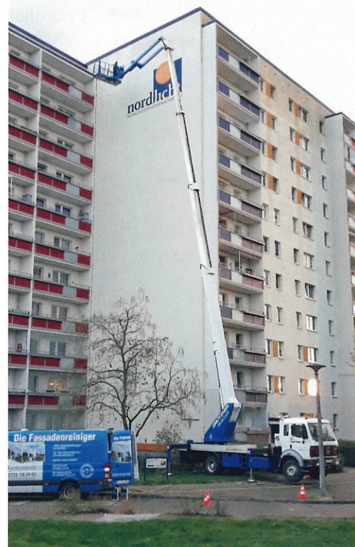
Fassadenreinigung am Giebel Borkheider Str. 1
